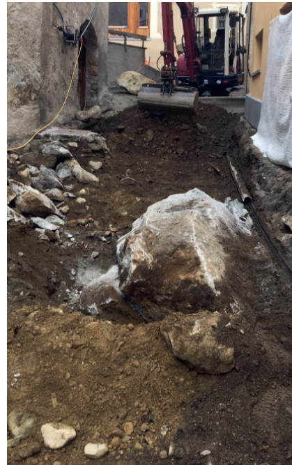
Strassenbau mit Findlingsfund
