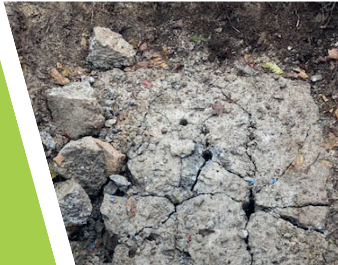
ASM Fahrleitungsfundament 150 × 150 cm und 200 cm tief im Zentrum von Aarwangen. Gesprengt mit 4 Ladungen (Bohrlöcher 80 cm tief)
